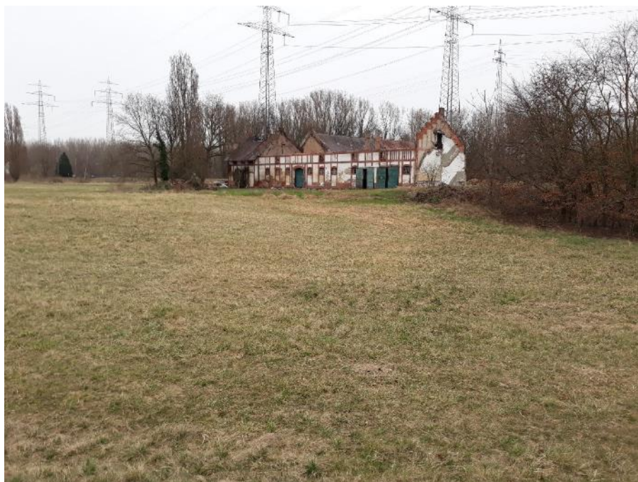
Foto 1: Blick nach Südosten auf die im westlichen Teil liegenden Gebäude des Rheinschanz-Mittelhofs.
