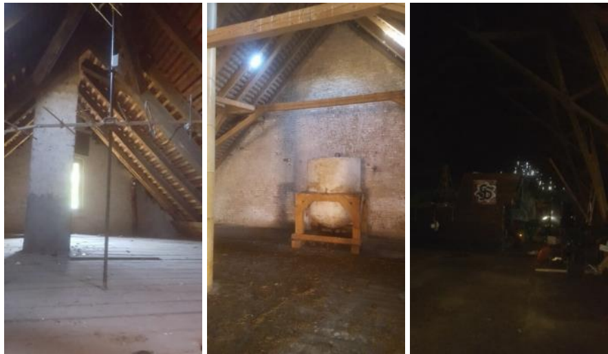
Foto 11: Beispiele für Dachbereiche der Gebäude im Untersuchungsgebiet (Links: Wohngebäude; Mitte: Stallanbau; rechts: Scheune).
